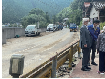
錦川増水現場 (山口・岩国市)
